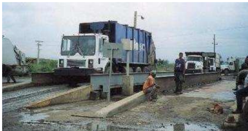
L'installation pour le pesage des déchets dans la décharge de Duquesa
