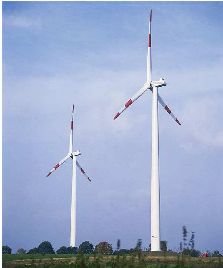
Figure 11 : éoliennes NEG-Micon 1,5 MW munies d'un balisage de jour ([www.neg-micon.com](http://www.neg-micon.com))
