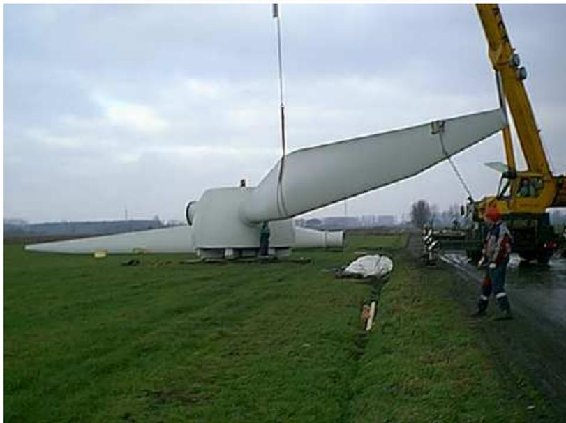
Figure 10 : Armature de la fondation, érection du mât et montage des pales de l'éolienne de Zandvleuge ([www.ecopower.be](http://www.ecopower.be))
