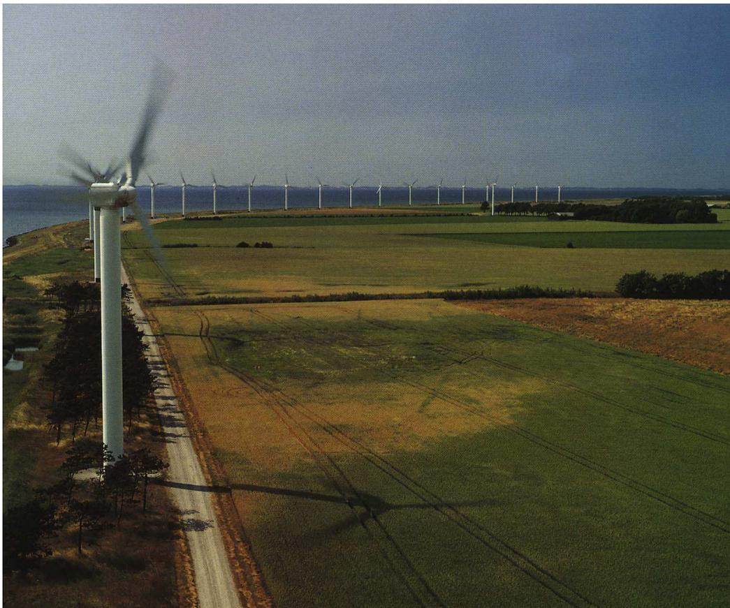
Figure 15 : alignement courbe d'éoliennes 400 KW à Kappel au Danemark (BIRK NIELSEN, 1996)
