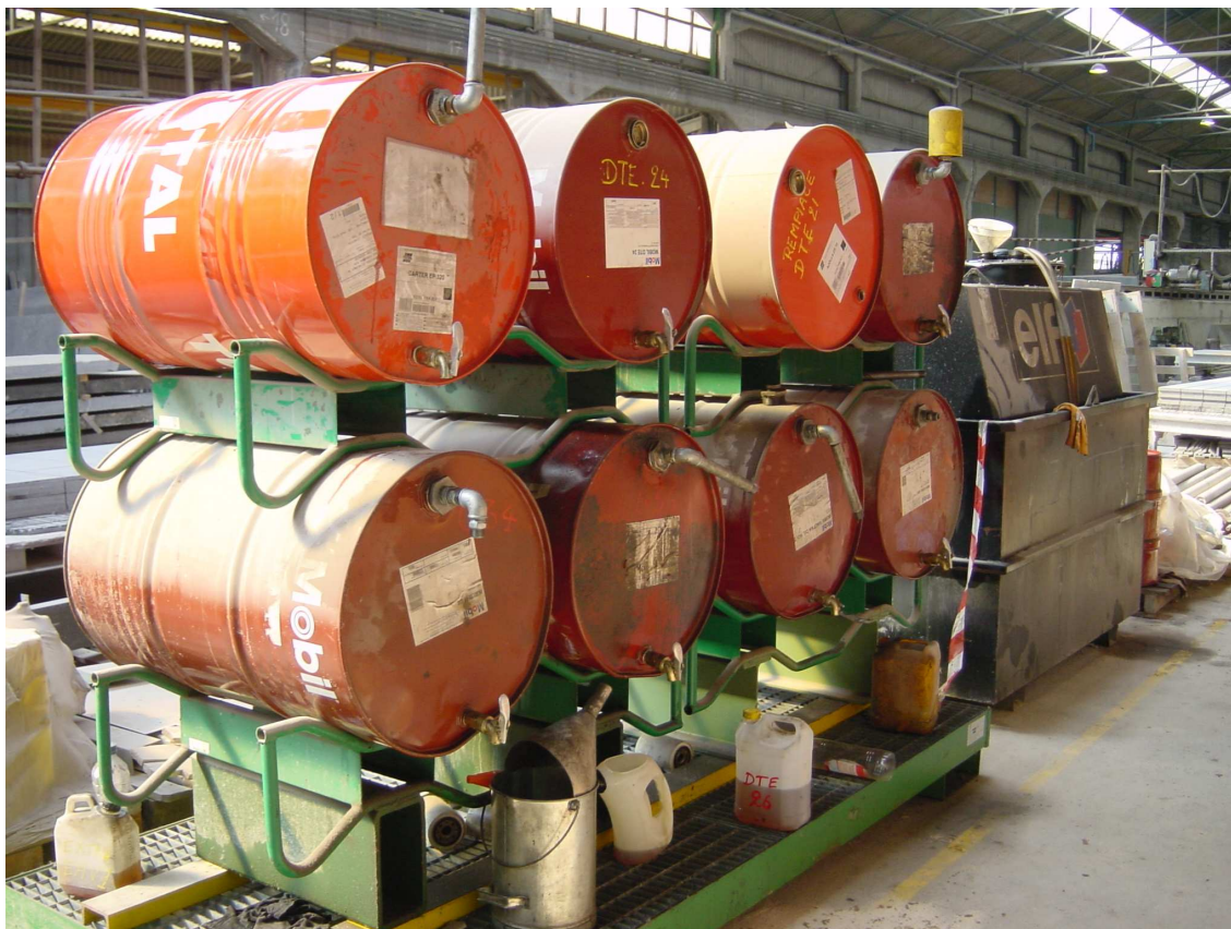
Figure 4. Bac de rétention en-dessous des fûts des huiles (avant-plan) et cuve métallique en double paroi d'acier (arrière-plan)
