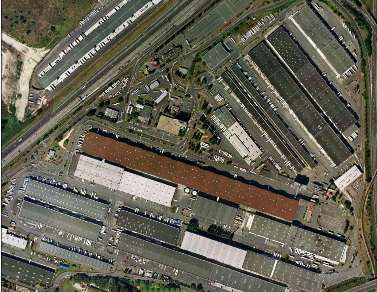
Figure 15 : le parc logistique « Garonor » à Aulnay-sous-Bois
