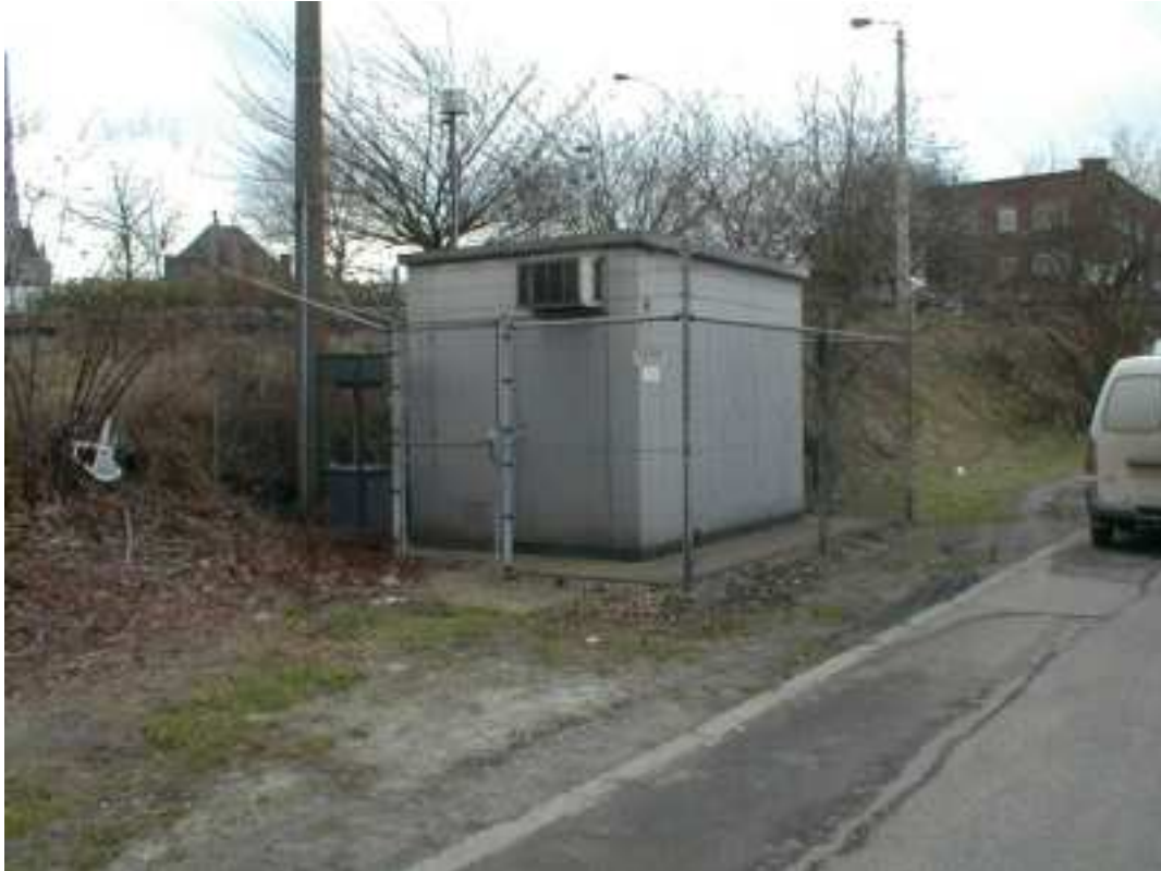
Fig. 3 : Station télémétrique de Marchienne-au-Pont, Quai du Sud (45R512) (TMCH01)
