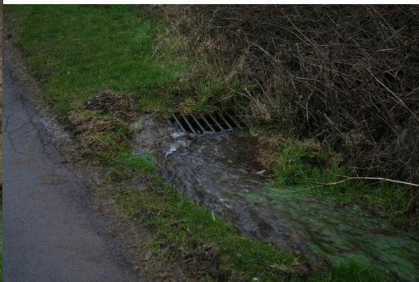
**Figure 14** : Caniveau récoltant l'écoulement (Photographie: G.Michel)
