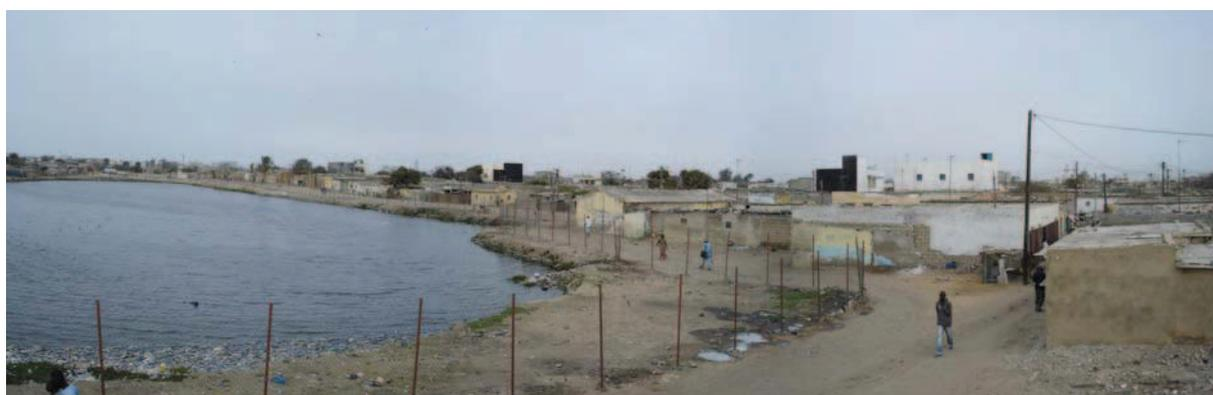
*Bassins de rétention des eaux de la nappe, réalisés dans le cadre du Programme « Plan Jaxaay »*
