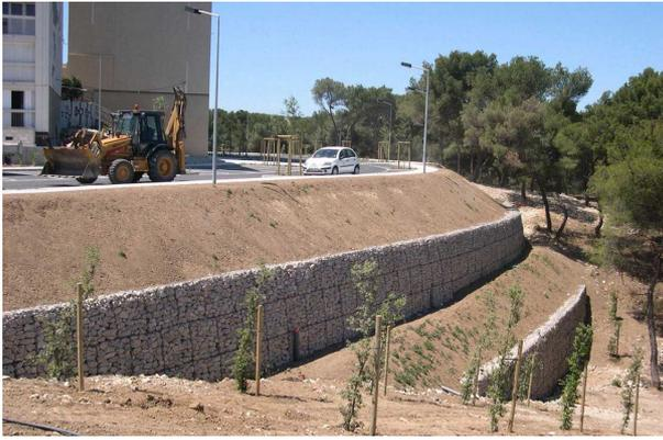
**FIG. 19:** Exemple d'emploi de gabions pour stabiliser une pente (source : Provence Travaux Publics S.A).
