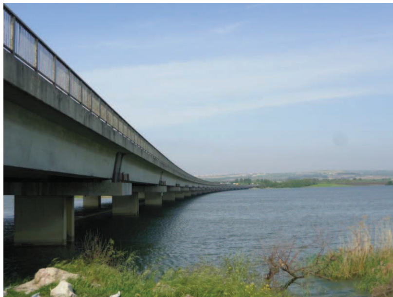
Annexe 8 : Trans European Motorway, traversant le réservoir de Büyükçekmece (Source : photo personnelle prise en mai 2013).
