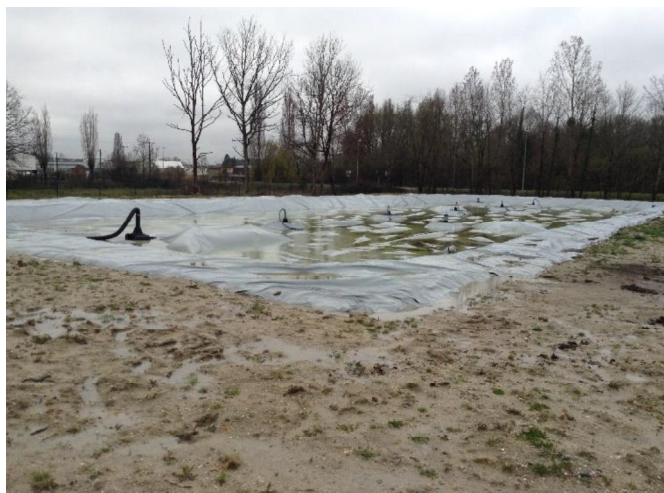
Fig. 22. Cuve de stockage du digestat liquide, prise à La Ferté Saint-Aubin (Photo personnelle, 31 mars 2016)
