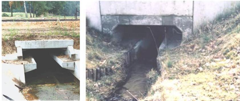
Figure 19. Exemples d'ouvrages hydrauliques modifiés pour permettre le passage de la faune (Pays-Bas). Source : Iuell *et al.*, 2003.
