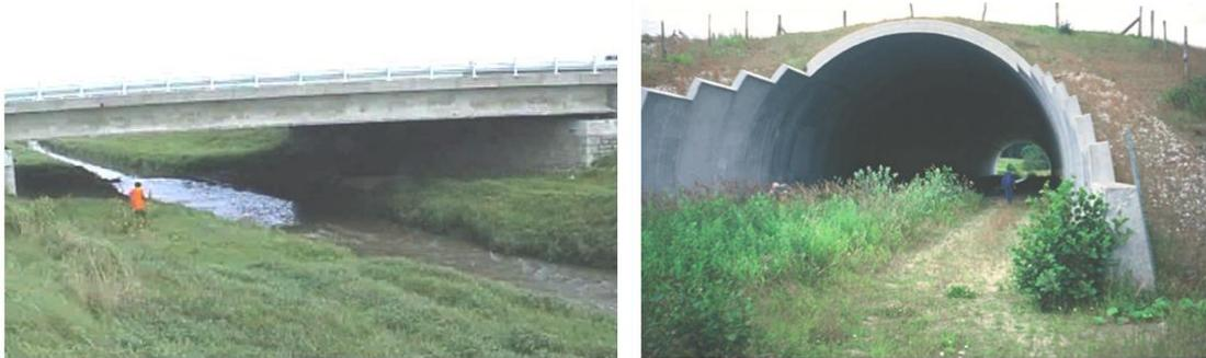
Figure 17. Exemple de passages à usages mixtes en république Tchèque et au Danemark. Source : Iuell *et al.*, 2003.
