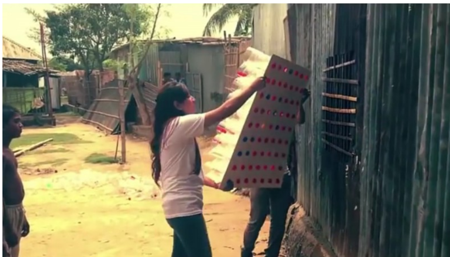
Figure 24 : L'Eco Cooler et son installation. Source : Nowshin, 2017.
