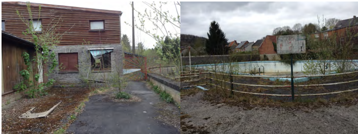
Fig. 10 : Ancienne piscine du camping communal, Viroinval, 06 avril 2017 (photo personnelle)
