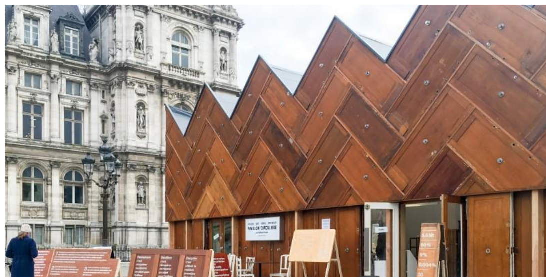
FIGURE 2 - PAVILLON CIRCULAIRE : PORTES EN BOIS RÉCUPÉRÉES DANS UN IMMEUBLE DE LOGEMENT UTILISÉES COMME BARDAGE EXTÉRIEUR (LE PAVILLON CIRCULAIRE, 2016)
