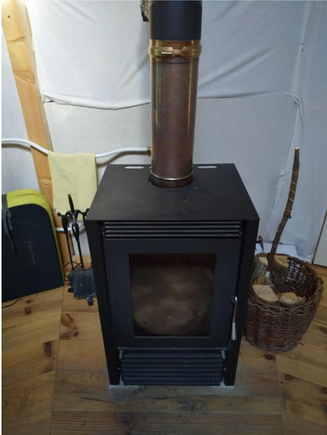
*Photo 8. Le poêle hydro se présente comme un poêle à bois générique. Sur la gauche, nous voyons un des tuyaux qui rejoint l'installation hydraulique à moitié dissimulée*
