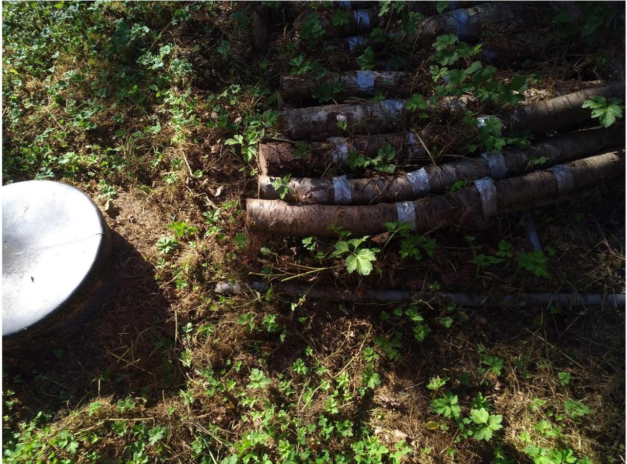
*Photo 11. Le puits perdu d'Aurélie et Timothée. A gauche, la cuve qui habille le puits. A sa droite, on peut distinguer le tuyau en socarex par lequel les eaux sont déversées*
