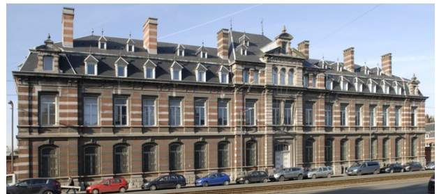
Figure 12 : Bâtiment A anciennes casernes d'Ixelles (photo : © Monuments & Sites – Bruxelles)
