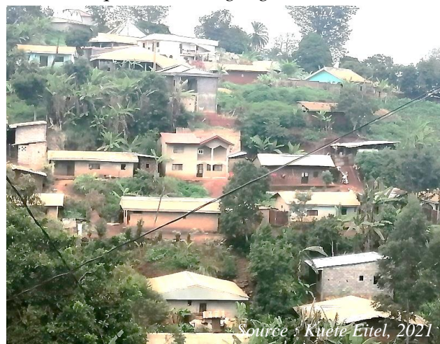
Photo 9: Constructions risqués sur le flanc d'une colline au quartier Toungang
