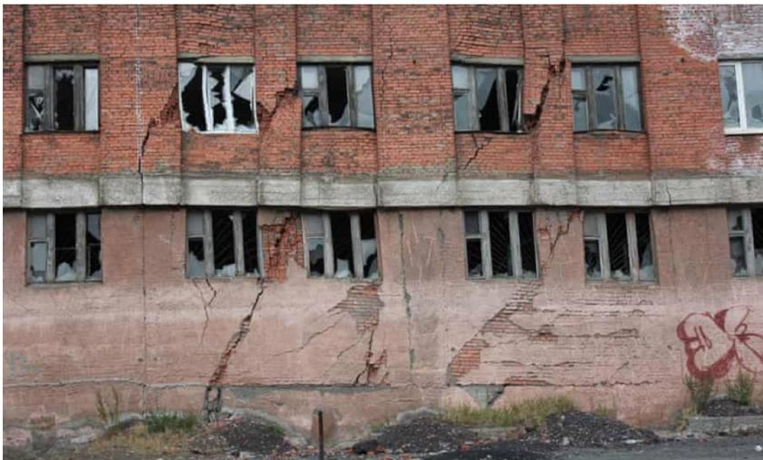
Fig. 4.7. Des bureaux abandonnés à Norilsk depuis 2009 suite à des fissures. (Lhun, A., 2016)
