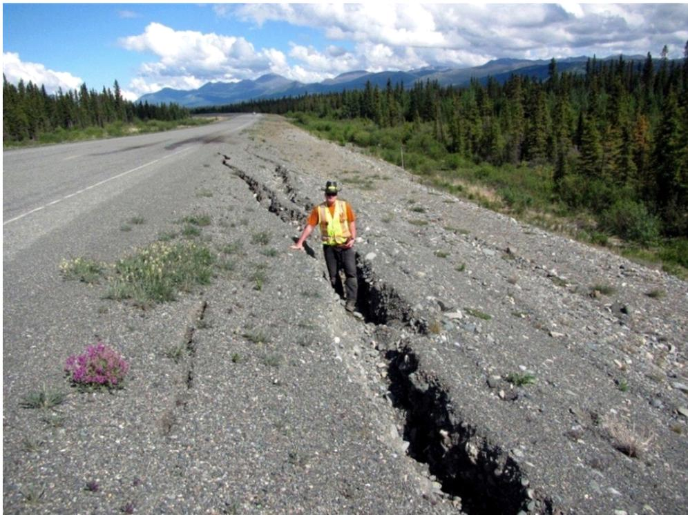
Fig. 4.2. Alaska Highway Photo de Paul Murchison à l'intérieur d'une faille causée par le dégel du permafrost. (Courtesy Yukon Research Centre and College in Quinn, G., 2016)
